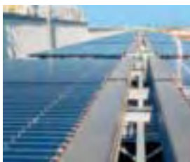
Abb. B.1.6–12 Flachdachmontage (liegend)
